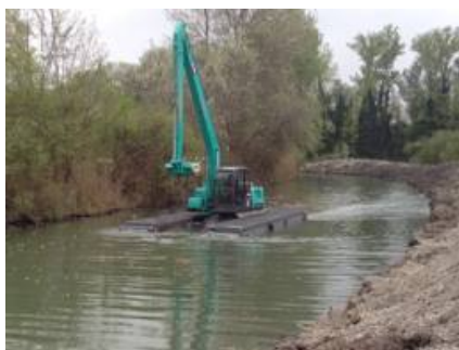
Draga che scava lungo i fiumi
